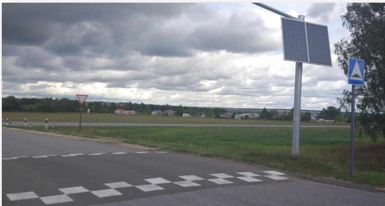
Перекресток, оборудованный искусственными неровностями и альтернативными источниками электроэнергии
