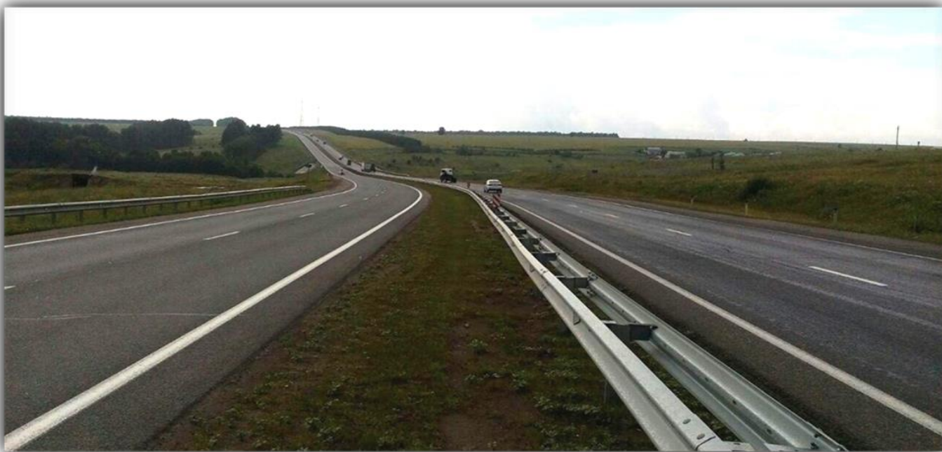
Обустройство барьерными ограждениями
