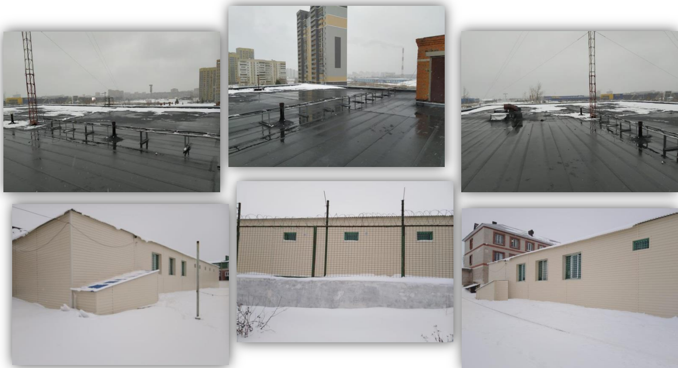
Проведены работы по ремонту кровли здания полка патрульно-постовой службы (г. Казань), здания изолятора временного содержания подозреваемых и обвиняемых (г. Нурлат)
