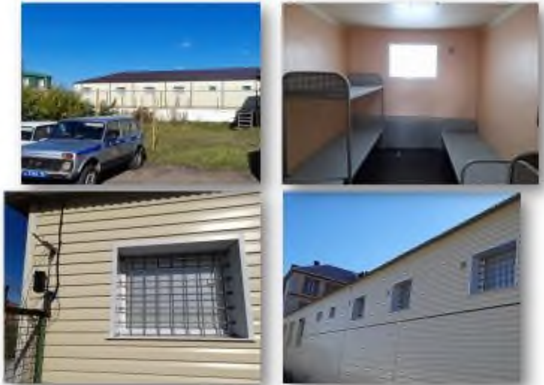
Отремонтированное здание изолятора временного содержания и специального приёмника отдела МВД России по Нурлатскому району
